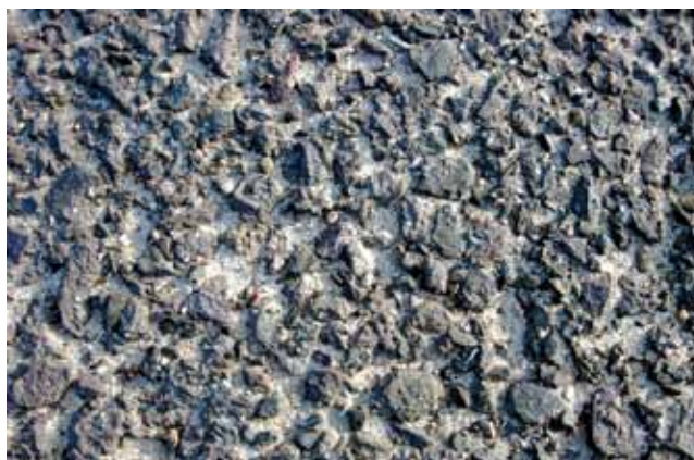
Rys. 7.1. Uszkodzenia warstwy ścieralnej (fot. K. Błażejowski)
