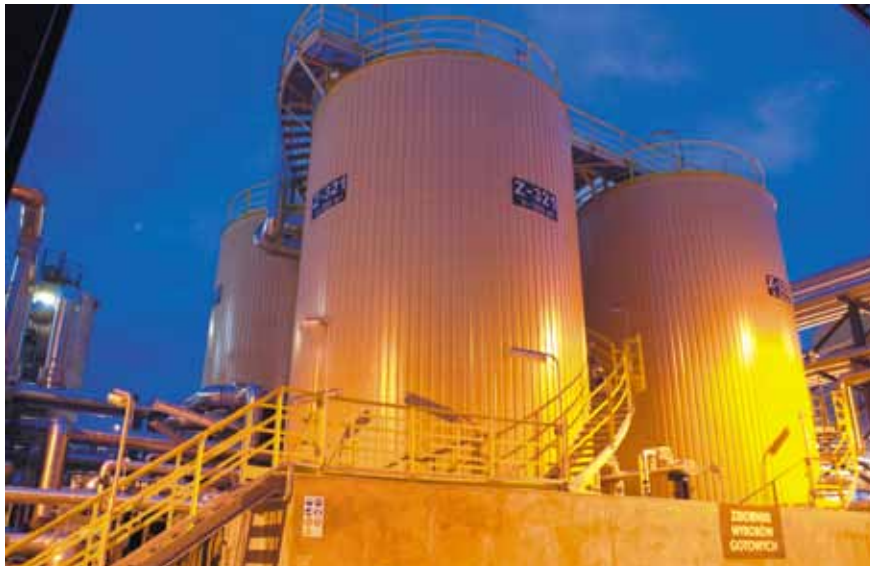
Rys. 5.1. Zbiorniki na asfalt modyfikowany, instalacja w Płocku (fot. ORLEN Asphalt sp. z o.o.)
